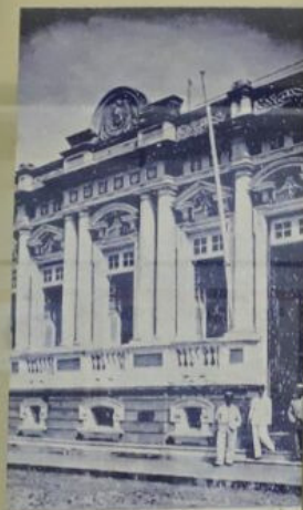
Palácio da Justiça, situado na Rua Barão de São Brás, sede do Poder Judiciário do Estado do Rio de Janeiro, construído em 1912, em 1913 e 1914, sob o projeto de 1912 e 1913, sob o projeto de 1912 e 1913, sob o projeto de 1912 e 1913.
